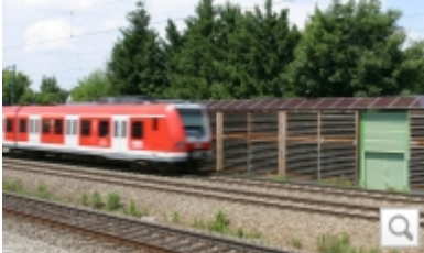
Lärmschutzwand bei Vaterstetten, Foto: DB AG/Annette Koch
